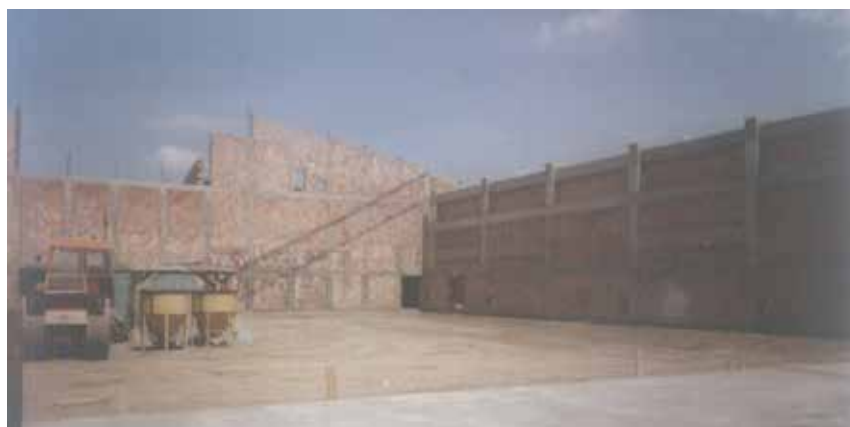
Hala w trakcie budowy
