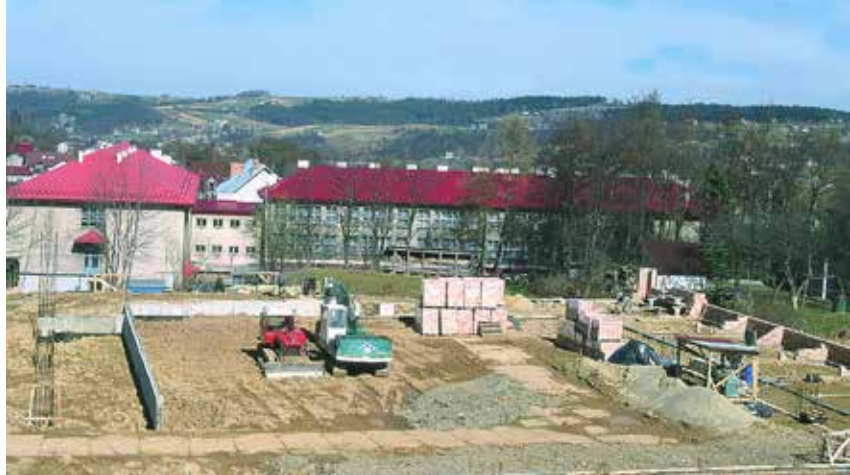
Budowa hali sportowe 2002.
