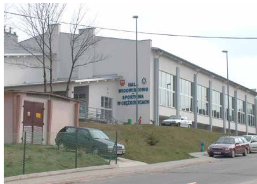
Hala widowiskowo- sportowa
