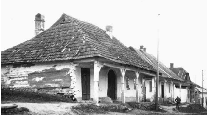
Domy przy ul. Grunwaldzkiej
